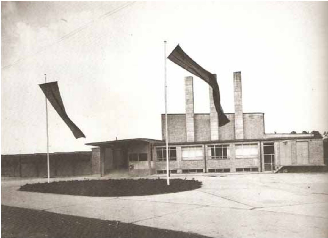
Abb. 5 Vorfahrtsbereich, erkennbar die Fugenstruktur der Betonfahrfläche, um 1930.
