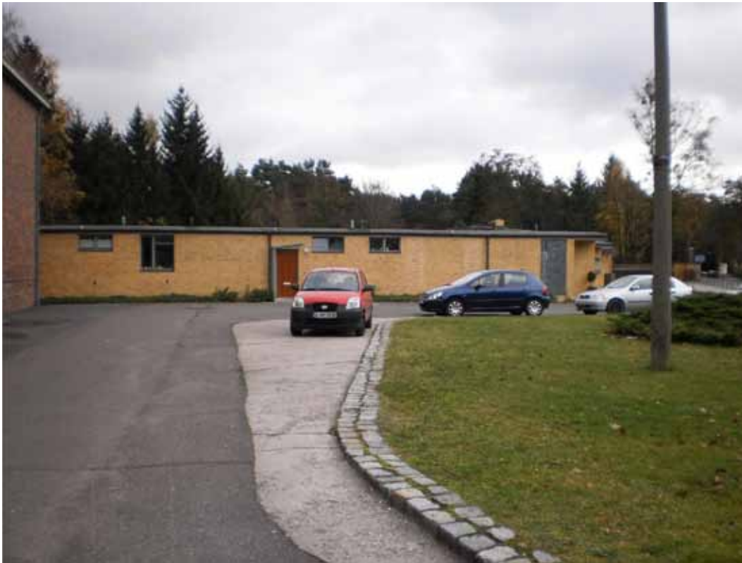
Abb. 25 Hannes-Meyer-Campus, Vorfahrtrondell mit Rest orig. Betonfahrfläche, 2013.
