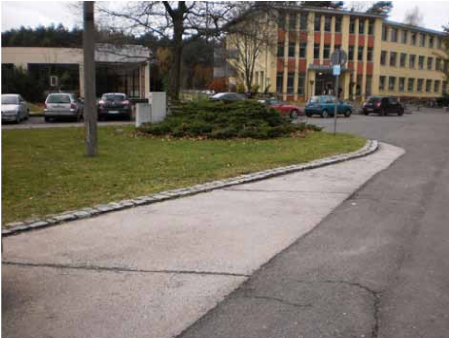
Referenz für Neugestaltung Fahrflächen: Bestandsrest orig. Betonfahrfläche Hannes-Meyer-Campus.
