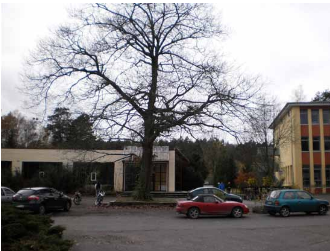
Abb. 26 Hannes-Meyer-Campus, Blick nach Westen auf ehem. Mensabau, 2013.
