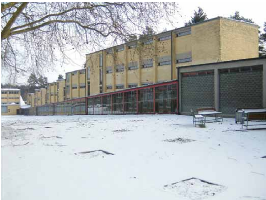
Abb. 28 Bereich Pergola, Aussparungen für Pflanzscheiben mit Pergolenpfosten und Platanen, 2014:
